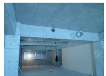
▲大きな梁が天井を渡っています。
